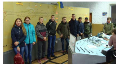
Дослідження пульта управління станції Чернігів
