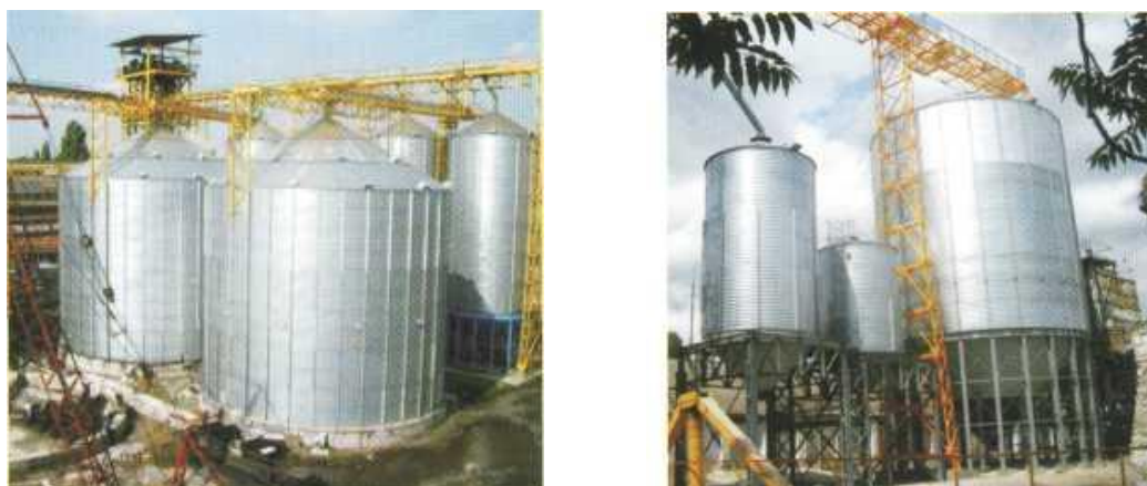
Рис.1. Загальний вид зерносховищ ВАТ «Карловській машинобудівний завод».
