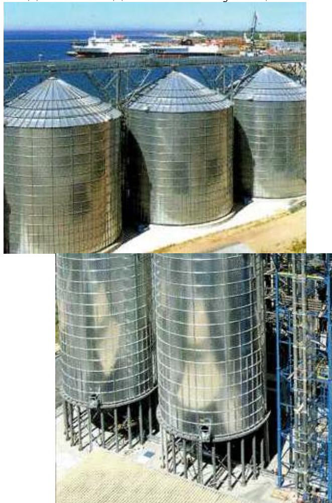
Рис.3. Силоси фірми «ARAJ» типу SPA
